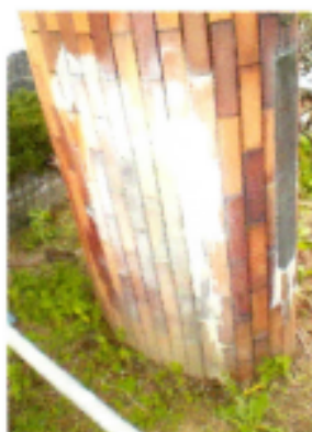
クリーニング工事前
