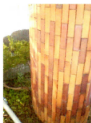
クリーニング工事後
