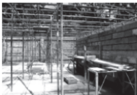
▲予定通り進行している建設現場
